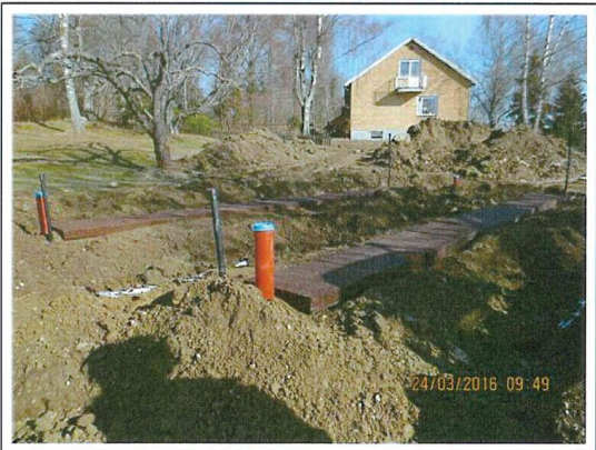
Isolerat spridarrör med 10 cm pordränksivor
