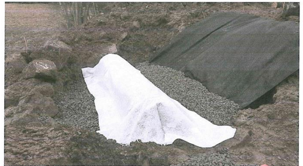
Infiltrationskassetter skyddas med fiberduk
