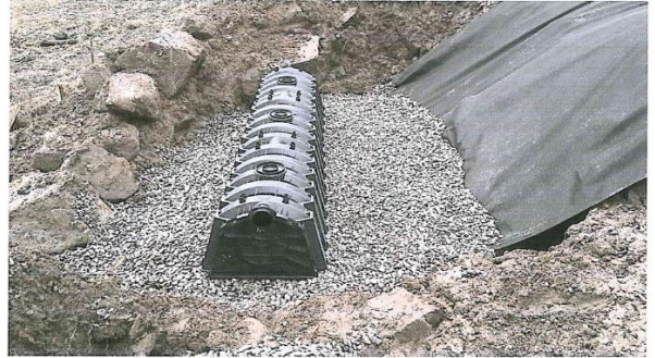
Efterpolering: Infiltrationskassetter på makadam 8-16
