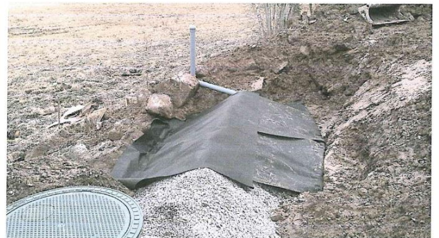
Efterpolering skyddas med fiberduk
